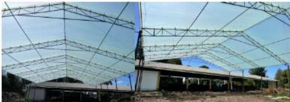
Figura 3. Ampliación del área de compostaje.
